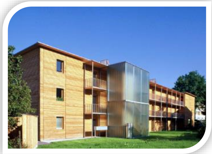
Réalisation de l'architecte autrichien Hermann Kaufmann
